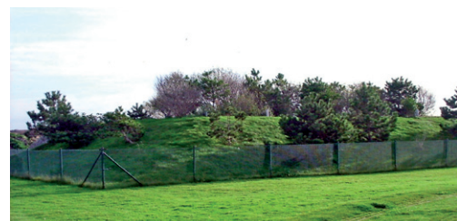
Abb. 4: Lysimeteranlage Norderney Nov. 2005
