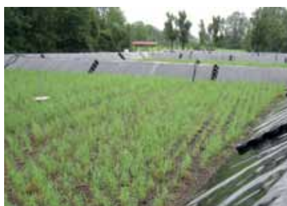
Die neue Klärschlammvererdungsanlage der Gemeinde Tacherting
