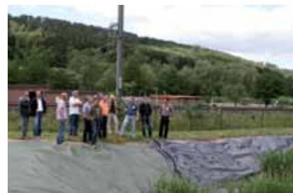
Besichtigung der Klärschlammvererdungs- anlage Helsa
