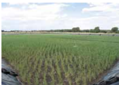
Die neue Klärschlammvererdungsanlage der Samtgemeinde Schwarmstedt
