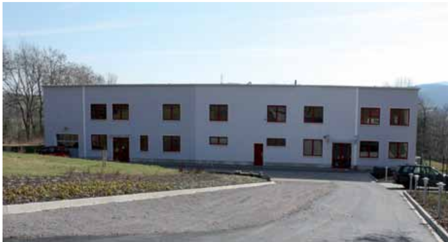
Neubau des Laborgebäudes PlanCoTec am östlichen Ortsrand von Neu-Eichenberg
