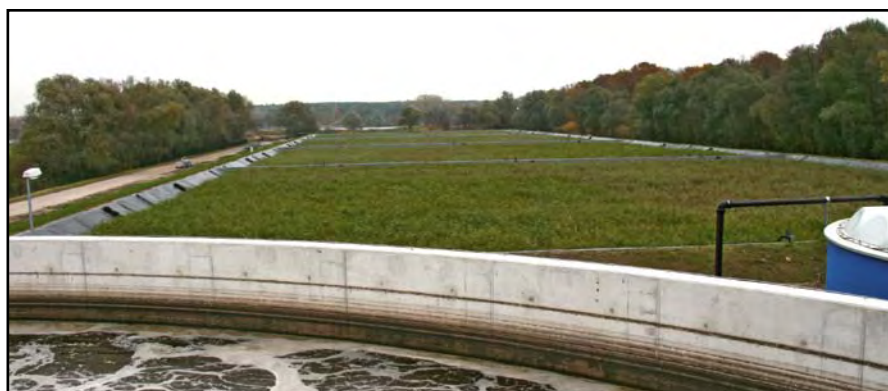
Die Klärschlammvererdungsanlage Kemnitz des WAZV Werder-Havelland
