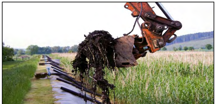
Der erste Aushub – Räumung der Klärschlammvererdungsanlage Förste
